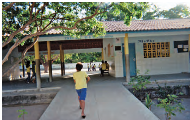
Escola Antônio Dutra de Sousa.
