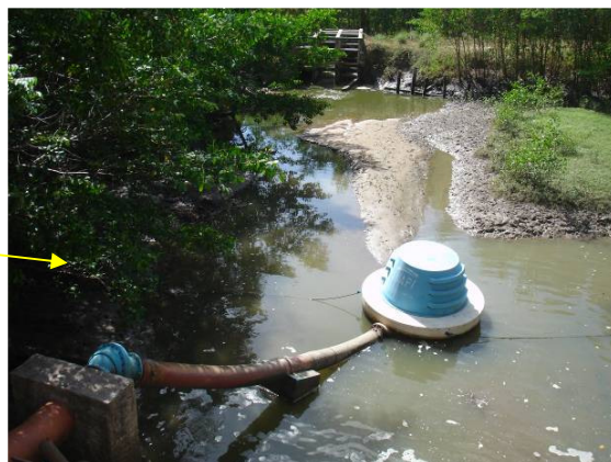
Foto 07 – Vista do Sistema de captação do empreendimento em operação com a utilização de bombas flutuantes.
