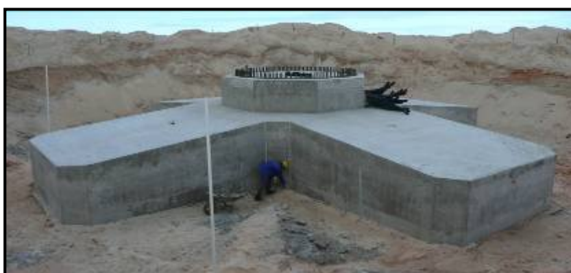
Figura 3.8 – Modelo de base de uma turbina aerogeradora. Fonte: Braselco, 2010.
