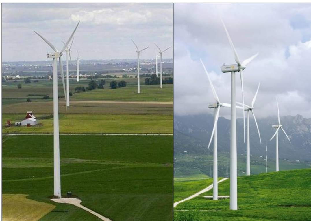
Figura 3.3 - Turbinas Eólicas Gamesa G87 2.000kW. Fonte: BRASELCO, 2010.
