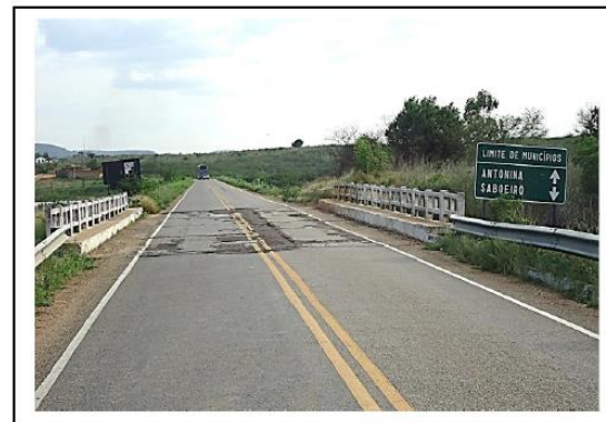
Est. 888+1,50: Ponte sobre o riacho Logradouro com vão de 26,50 m e placa alusiva à divisa entre os municípios de Antonina do Norte e Saboeiro.
