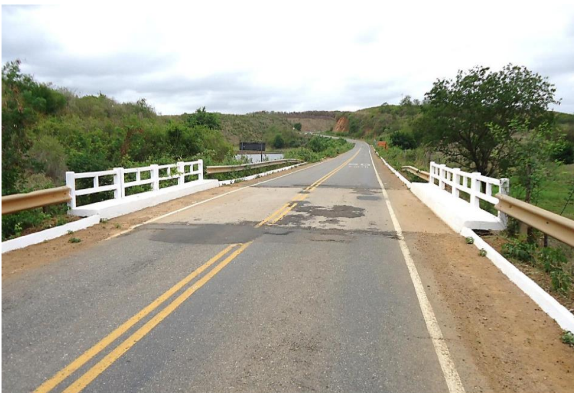
Foto 18 - Ponte sobre Riacho Montalvana – vão de 8,80 m. Presença de vegetação ciliar
