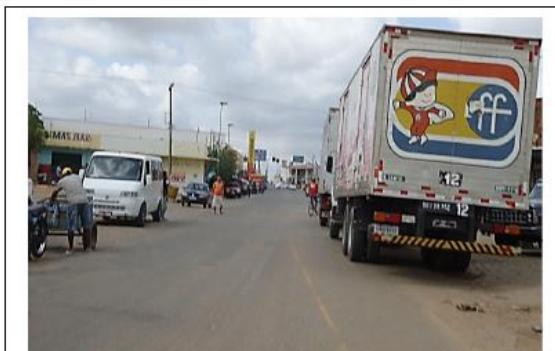
Final do trecho: Travessia de Campos Sales, conflituosa, podendo haver melhoramentos.
