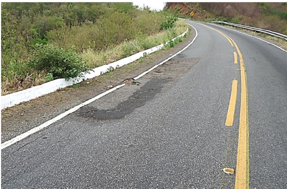
Foto 16 – Km 3,60 da Rodovia CE-371, com Curva bem acentuada, aumentando riscos de acidentes
