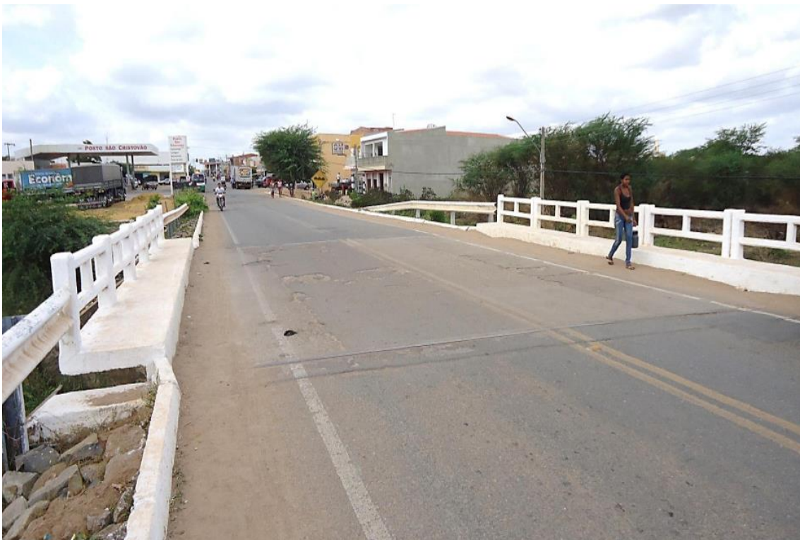
Foto 20 – Ponte sobre o Riacho Caldeirão na área urbana de Campos Sales
