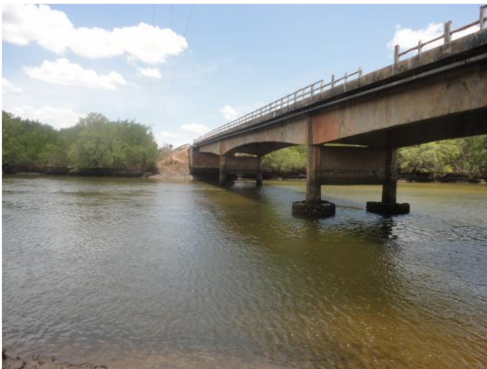
Foto 6 – Ponte sobre o rio Timonha
