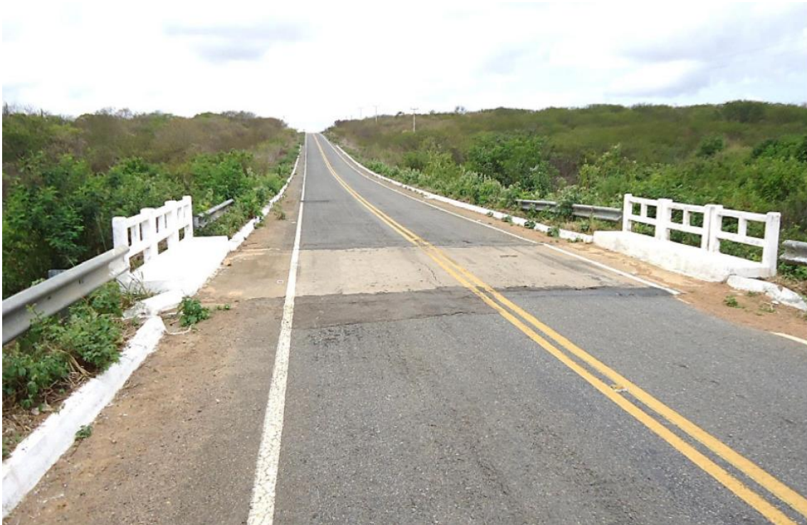
Foto 19 – Ponte sobre Riacho sem Nome – vão de 4,60 m. Matas ciliares preservadas
