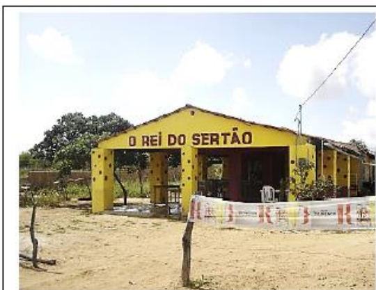
Km 47,8 (LE): Bar no lado oposto do acesso a Itaguá, com distanciamento adequado da rodovia sugerindo comidas típicas sertanejas..
