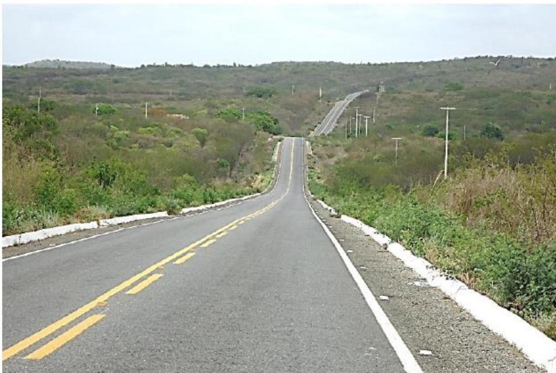
Foto 15 – Segmento com rampas longas, e ausência de terceiras faixas. Observa-se drenagem superficial em bom estado, à direita
