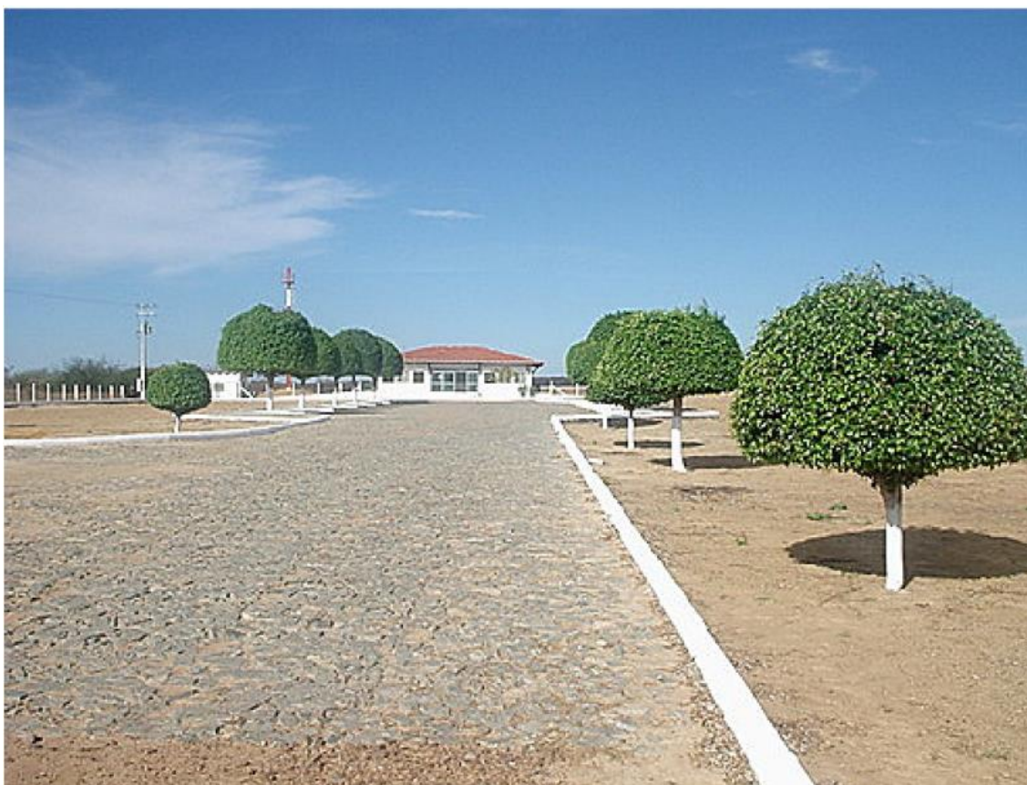
Foto 25 - Aeroporto de Campos Sales de abrangência regional, com estrutura de embarque/desembarque de passageiros
