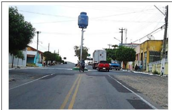
Início do trecho: Travessia Antonina do Norte com 1,40 km, com 300,00 m em pista dupla.
