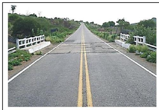
Est. 718+11,5: Ponte sobre o rio Jatirana com vão de 10,80 m e vegetação ciliar rasteira e arbustiva.
