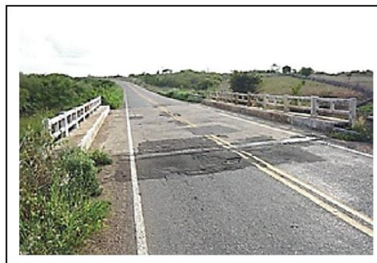
Est. 1034+2,50: Ponte sobre o Rio São Paulo. Vão de 16,10 m
