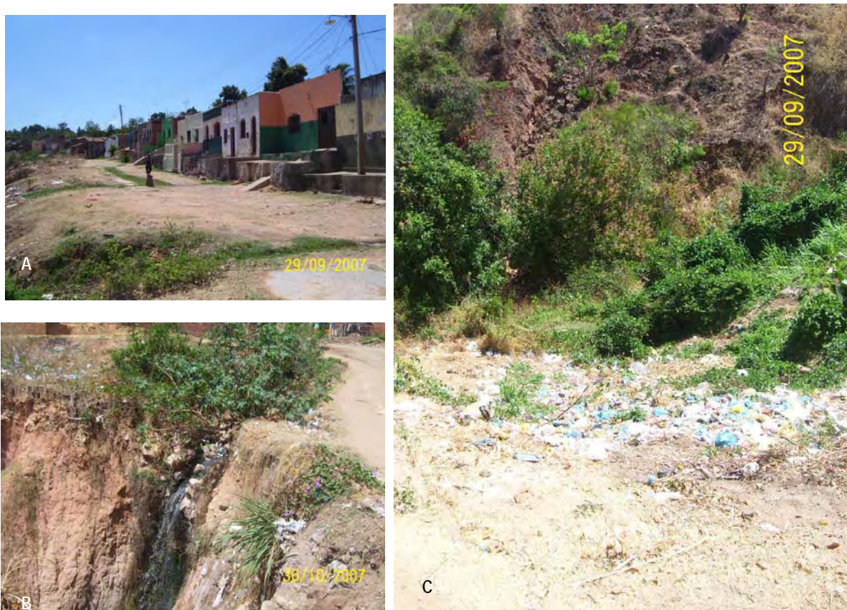
Foto 4: Área da voçoroca do Parque do Seminário, onde são observadas as residências em área de risco (A), deságüe de drenagem no início da área da voçoroca (B) e sua utilização para a deposição de resíduos sólidos.
