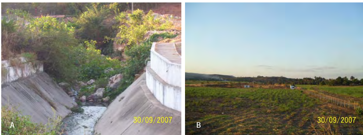
Foto 6: Canalização do leito do Rio Granjeiro (A), e área de alagamento a jusante do canal (B).
