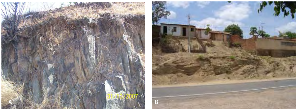
Foto 32: Encosta existente na CE 284, na entrada da cidade de Farias Brito (B), e detalhe da rocha gnáissica existente (A).
