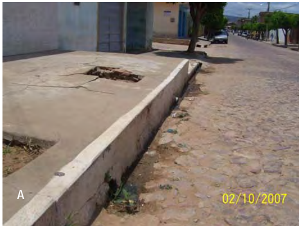
Foto 13: Ligações de águas servidas diretamente nas ruas e vias do centro da cidade de Juazeiro do Norte (A) e a estação de tratamento de esgotos existente (B).
