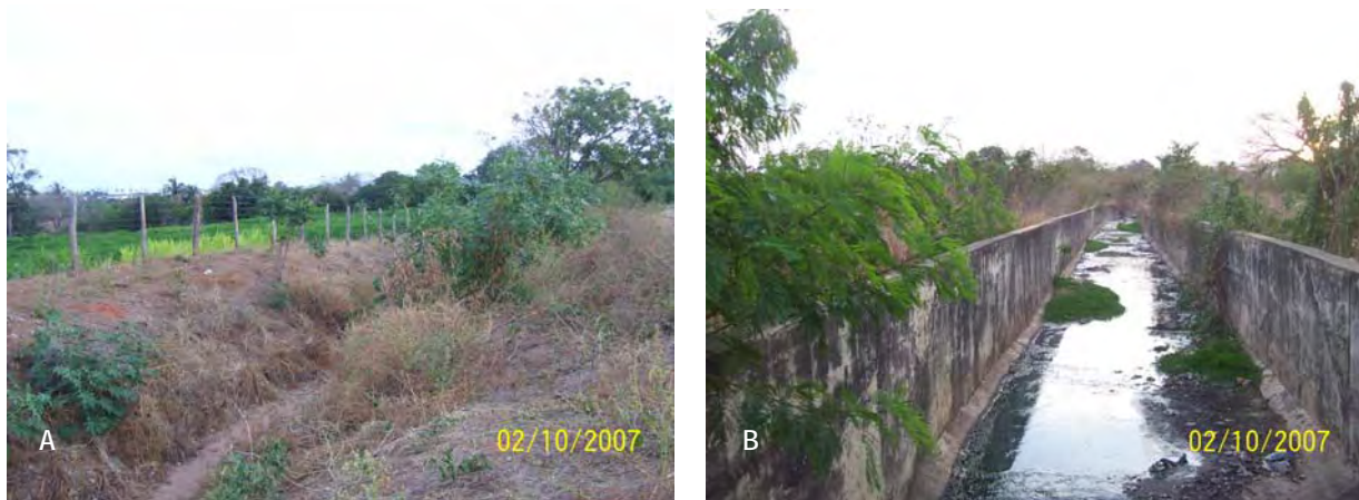
Foto 14: Riacho Timbaúba, dentro da área da 1º Etapa do Parque das Timbaúbas (A) e sua canalização com os efluentes da estação de tratamento de esgotos da CAGECE, existente (B).
