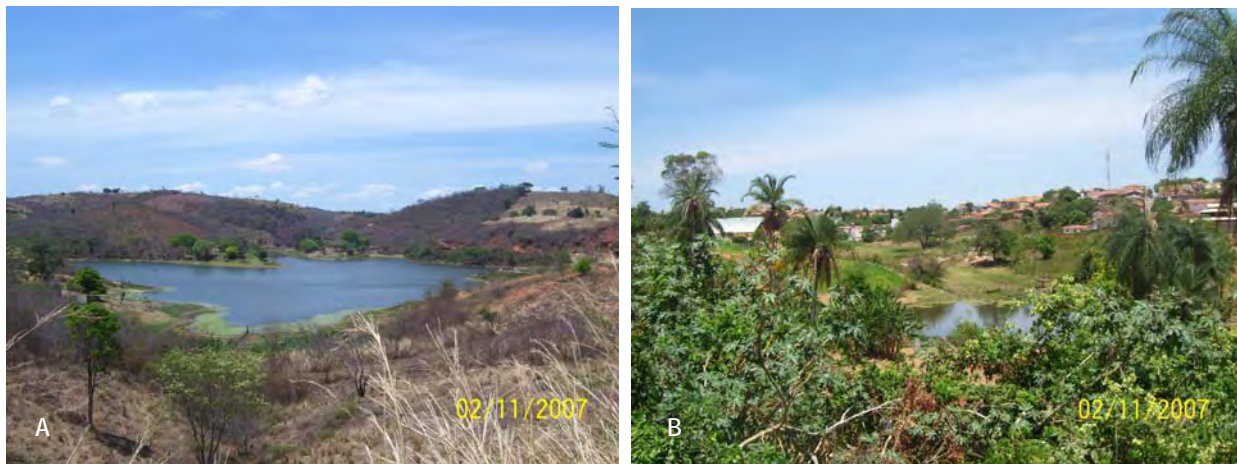
Foto 27: Açude que abastece a cidade de Caririçu (A) e pequena coleção de água a jusante do primeiro açude que recebe as contribuições da drenagem e águas servidas.
