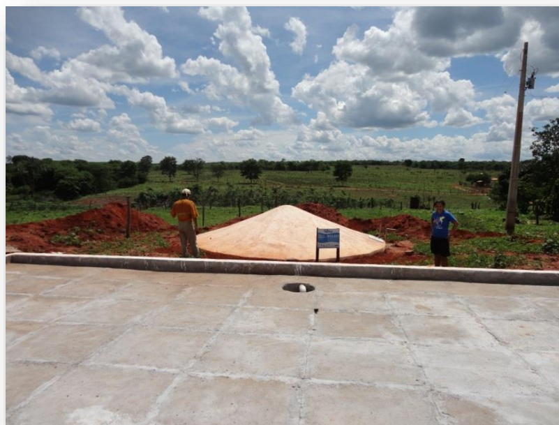
Figura 18: Calçadão concluído, mostrando as placas do piso devidamente rejuntadas
