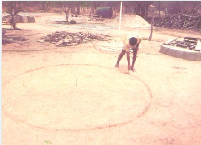
Figura 3: Marcação da área da cisterna
