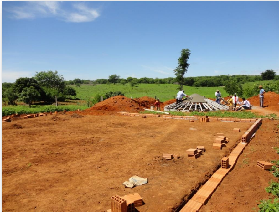
Figura 16: Construção do Calçadão
