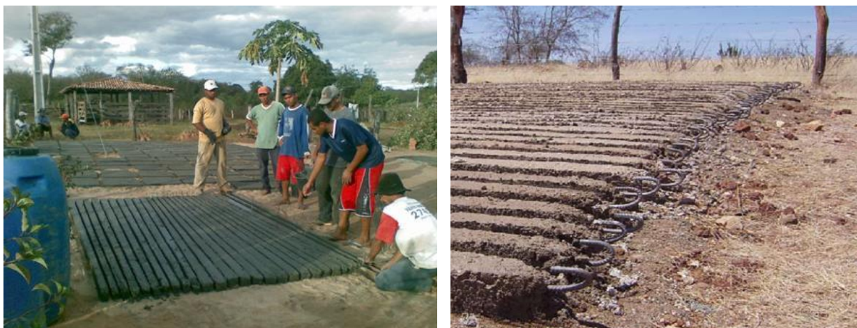
Figura 8: Confecção dos caibros da cobertura da cisterna
